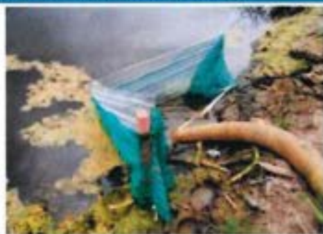
Exemples de filtrations doublant la crépine pour une vidange « sécurisée » des mares.
